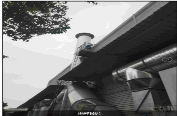
监测现场照片
